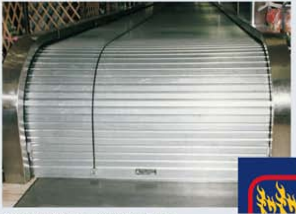
fire protection escalator door
